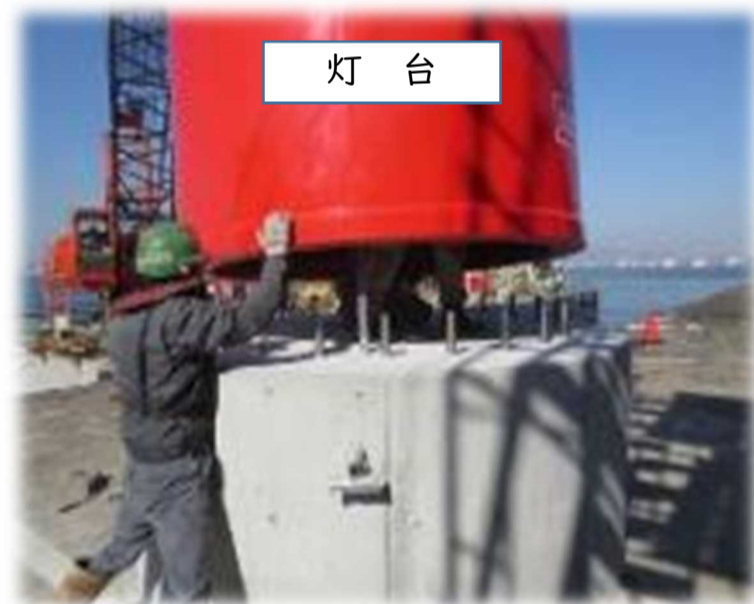
【海水浸入防止対策工事の様子】
