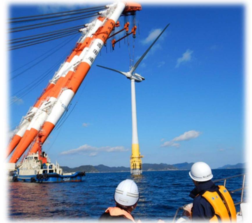
【洋上風力発電設備の設置の様子】
